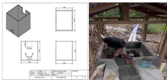
Gambar 9. Bak Penenang
