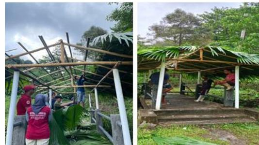
Gambar 8. Proses pemasangan atap daun woka
